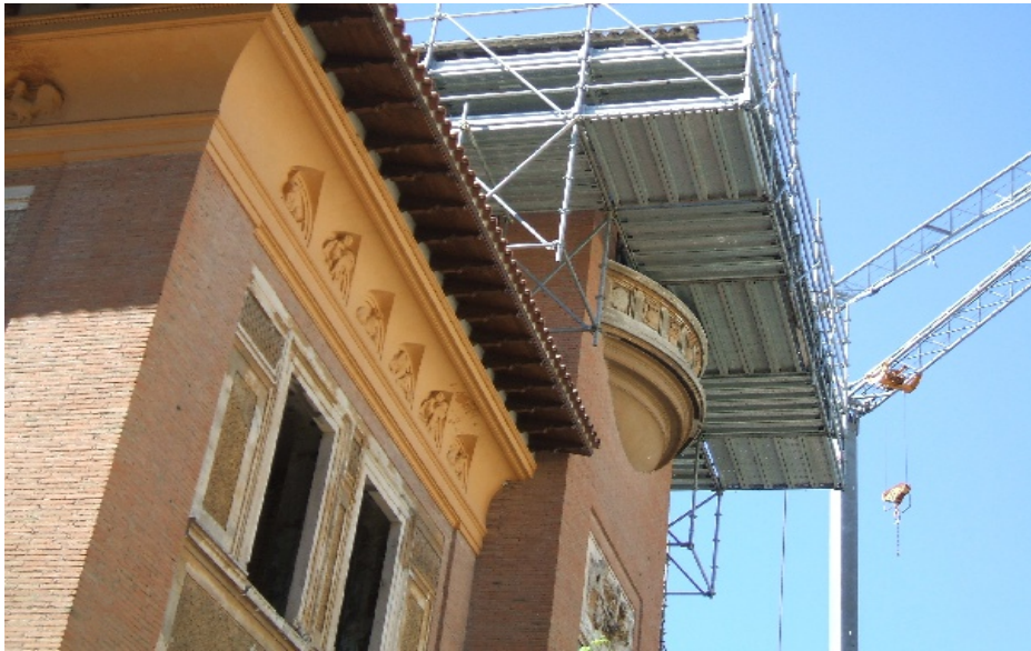
particolare ravvicinato dello sbalzo
