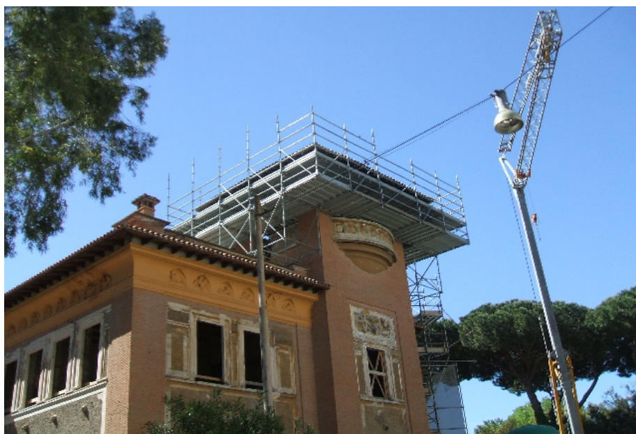
ponteggio a sbalzo
